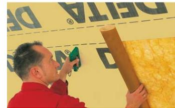
Пароизоляционная плёнка с функцией ограниченной диффузии пара
