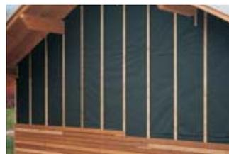
Ветрозащитная и гидроизоляционная плёнка для фасада с открытыми швами в облицовке.
