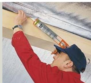
Клей предназначен для герметичного воздухопроницаемого соединения любой пароизоляции с каменной кладкой, металлическими и деревянными элементами крыши.
