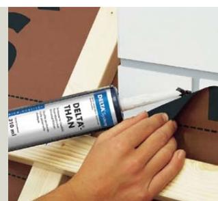
Сохраняющий прочность и эластичность на протяжении длительного времени клей из особого каучука. Только для наружного использования.
